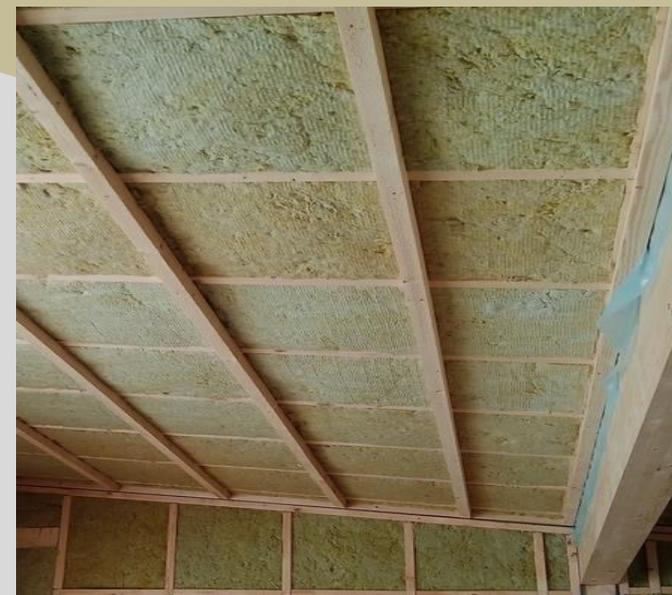
Энергоэффективность, тоже является максимальным преимуществом возведения каркасного дома через систему адаптеров, так как плиты утеплителя укладываются горизонтально с шагом в 1220 мм без каких-либо срезов и вставок, что способствует качественной теплоизоляции теплого контура. Хотим отметить, что при использовании электричества для отопительного оборудования, средний платеж за все энергоснабжения дома в самый холодный месяц года не превышает 5000 рублей
