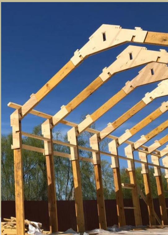
Срок строительства – это одно из главных преимуществ возведения каркасного дома через систему адаптеров. Данная технология соединений конструктивных элементов силового каркаса позволяет ввести в эксплуатацию дом на 48 м<sup>2</sup> в среднем за 2-6 недель. Вам остается только наполнить жилое пространство мебелью и бытовым оборудованием, въехать и жить
