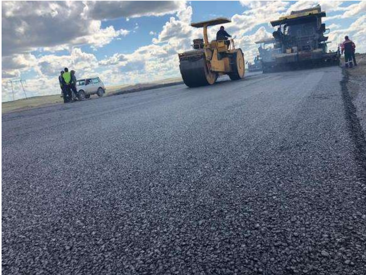
Укладка слоя покрытия
