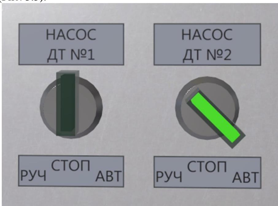
Рисунок 3.5 – Тумблер насоса дизтоплива № 1 в положении СТОП; тумблер насоса дизтоплива № 2 в положении АВТ (автоматическое управление)
