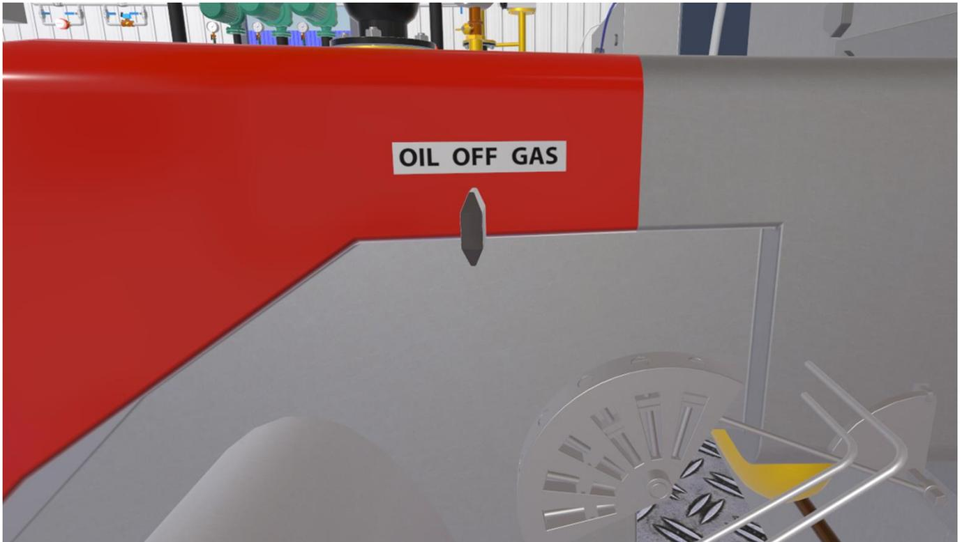
Рисунок 3.8 – Горелка комбинированная с тумблером выбора топлива
