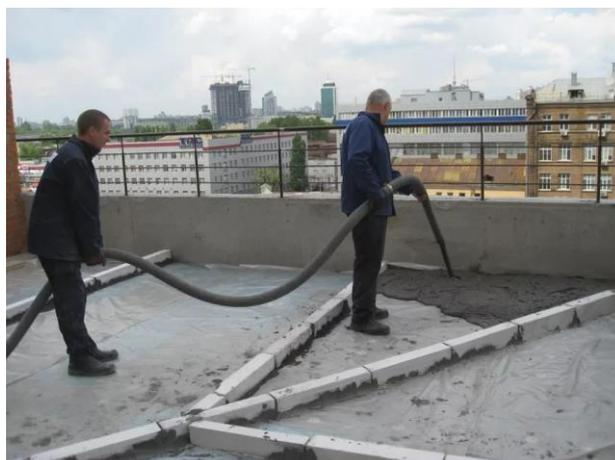
4.3.4. При устройстве пенобетонной теплоизоляции начинать заливку надо с дальних углов, в местах расположения приёмных воронок водостока делая локальные понижения уровня на 20–30 мм в радиусе 500мм от воронки.
