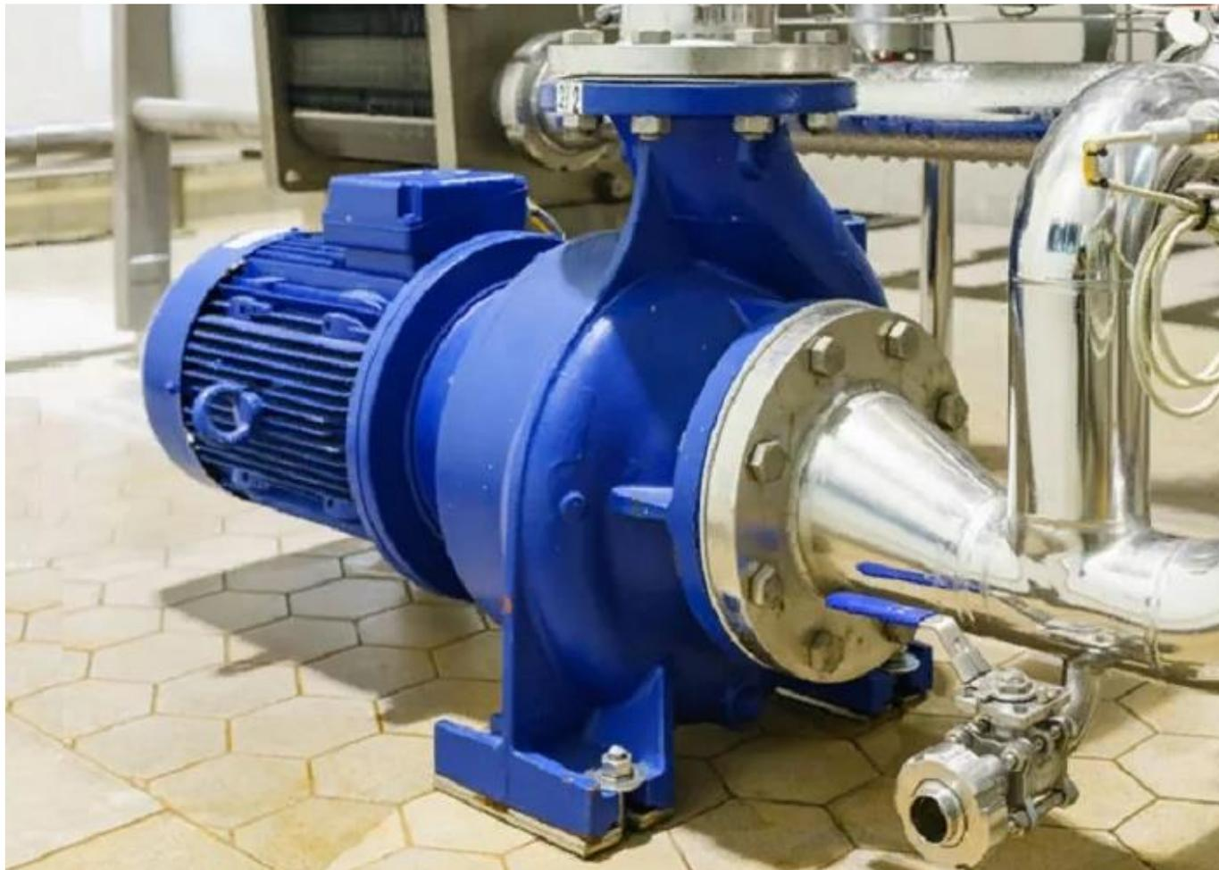
Центробежный насос- это насос, в котором движение жидкости и необходимый напор создаются за счёт центробежной силы, возникающей при воздействии лопастей рабочего колеса на жидкость.
